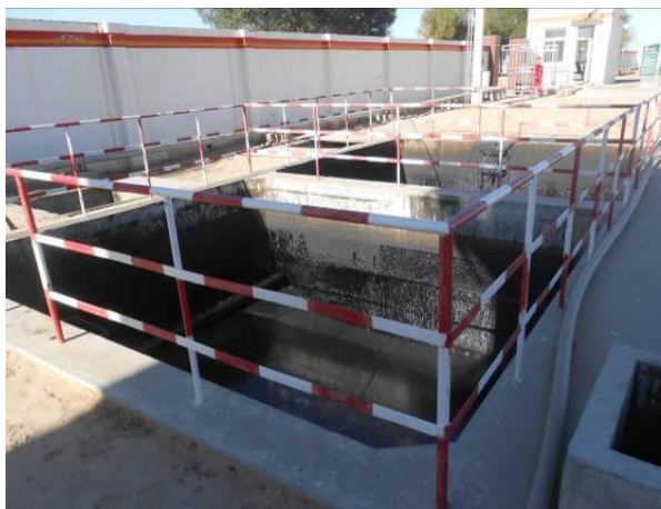
华一集输站内污油池
