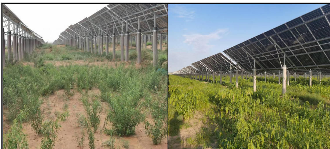
光伏板安装完成后的地貌
