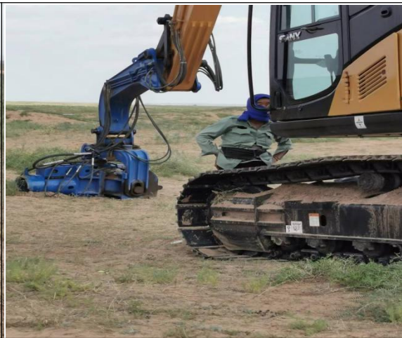
基础桩底部清理
