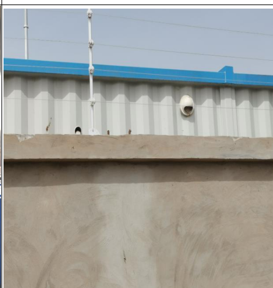
厨房油烟净化后的排放口
