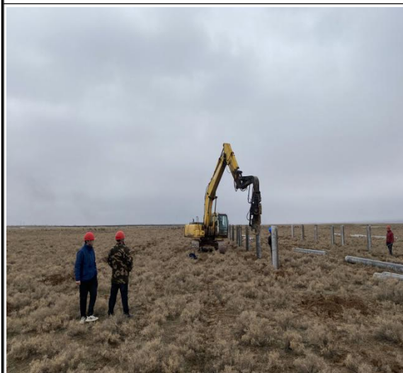
基础桩的施工过程
