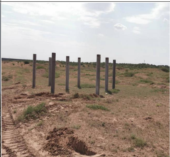
部分成品桩施工完成后的地貌
