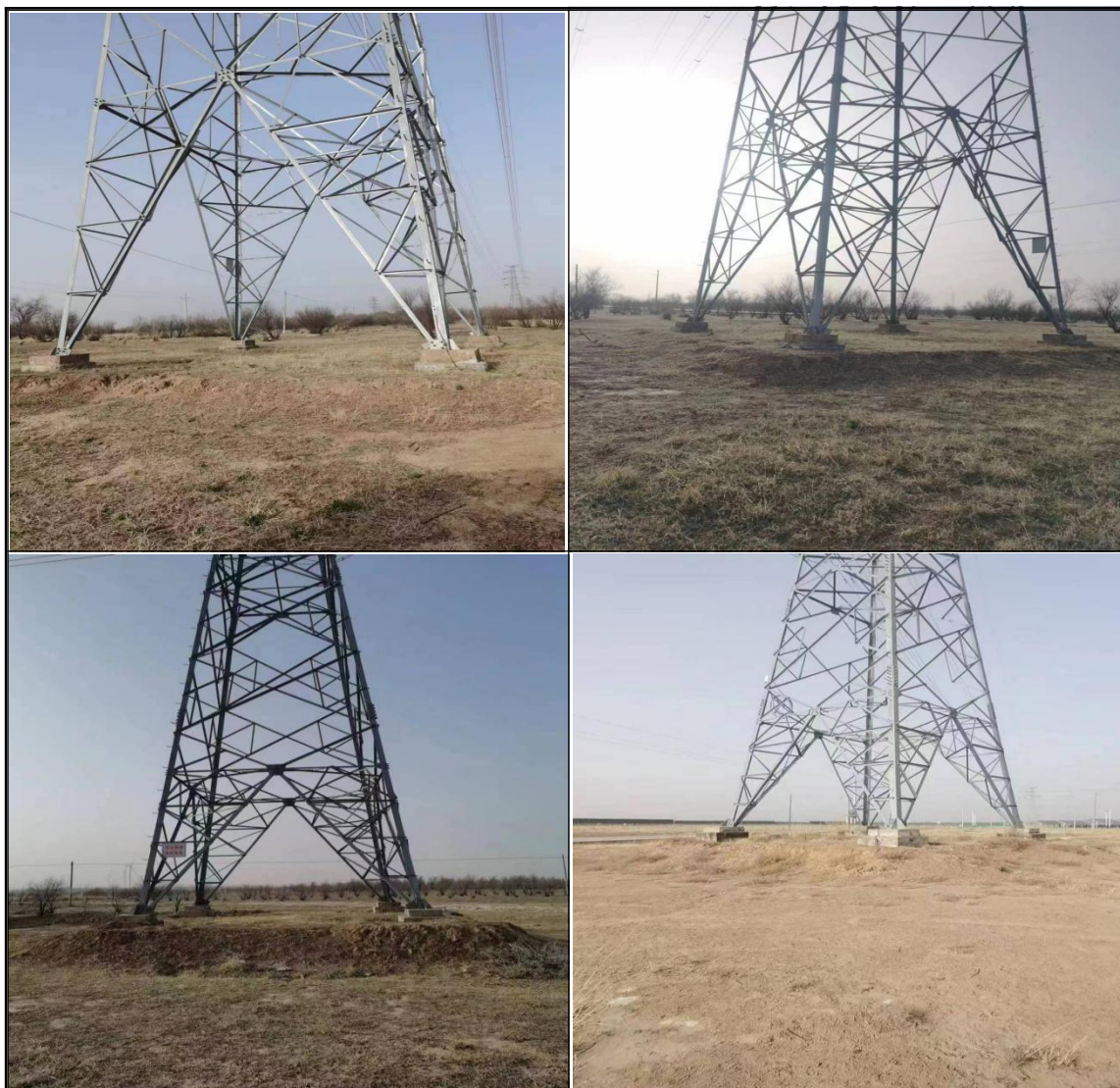
各塔基施工结束后生态恢复情况
